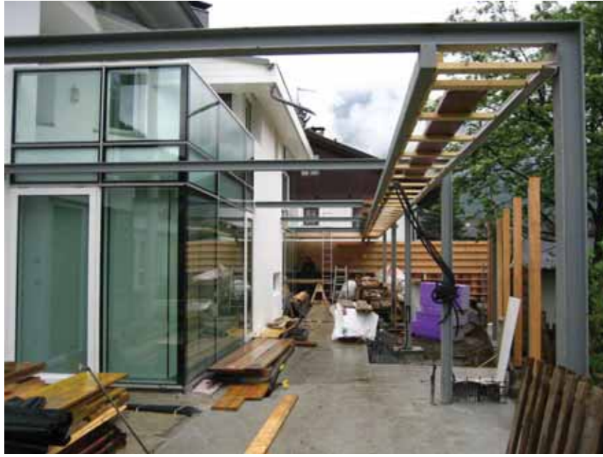
FASE DI COSTRUZIONE DEL SISTEMA DI SUPPORTO DEL TENDAGGIO ESTERNO.
