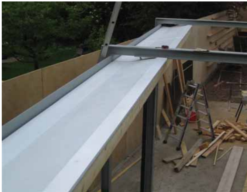
FASE DI COSTRUZIONE DEL SISTEMA DI SUPPORTO DEL TENDAGGIO ESTERNO, LA SEZIONE OBLIQUA CONSENTE IN LAMIERA CONSENTE DI ALLOGGIARE IL RULLO DELLA TENDA.
