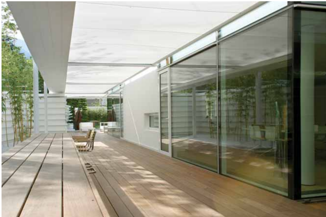
PROSPETTO SUD, IL TENDAGGIO OLTRE A PROTEGGERE DALLA RADIAZIONE SOLARE CIRCOSCRIVE UN VERO E PROPRIO AMBIENTE ESTERNO.
