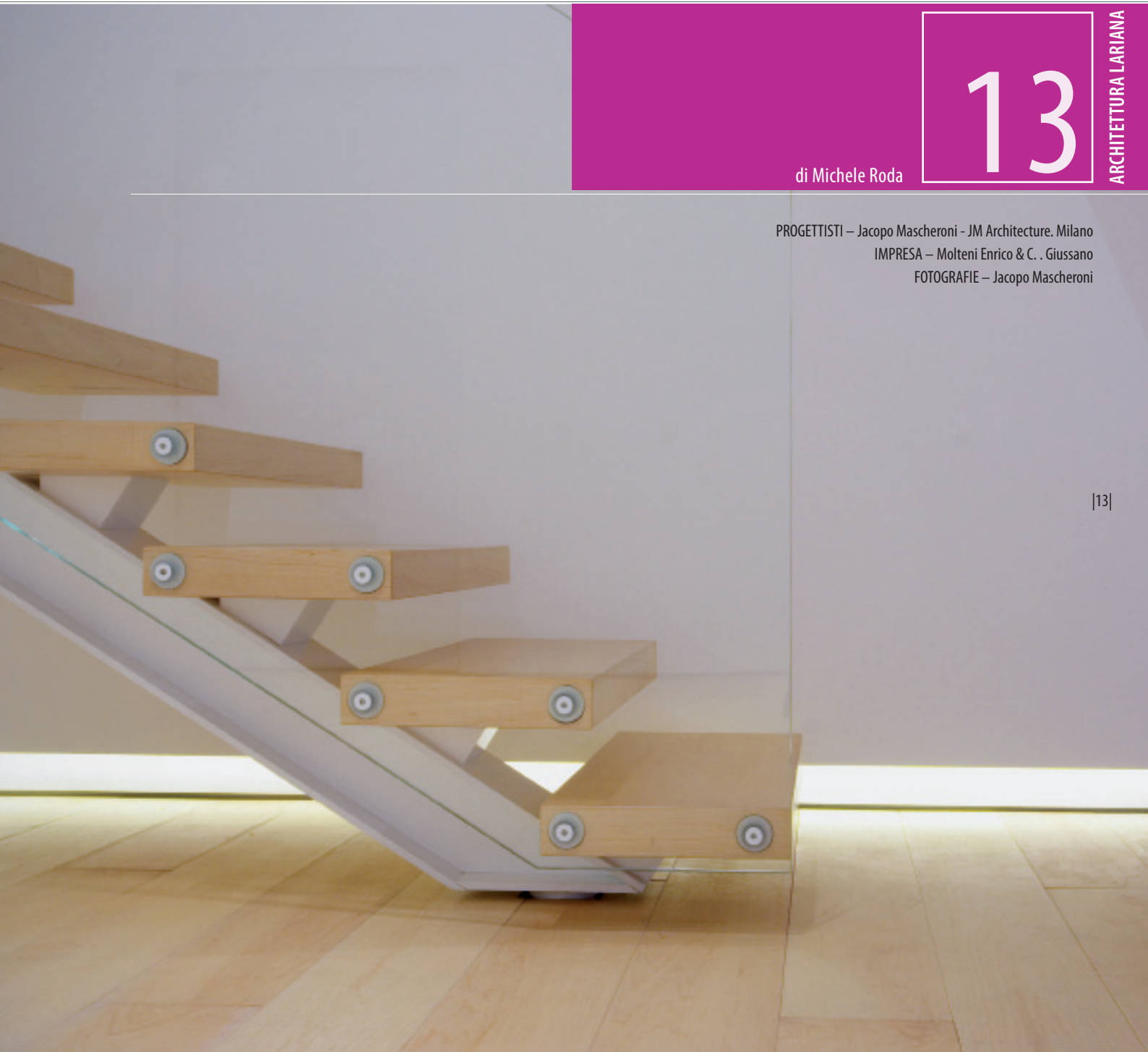
Particolare della scala con struttura metallica, gradini in legno e parapetto in vetro
